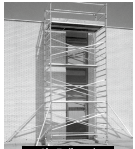
Alu-Roll- und Spezialgerüst - auf Kundenwunsch angefertigt
